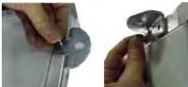
Figura 1 - Fissaggio delle staffe fornite a corredo
